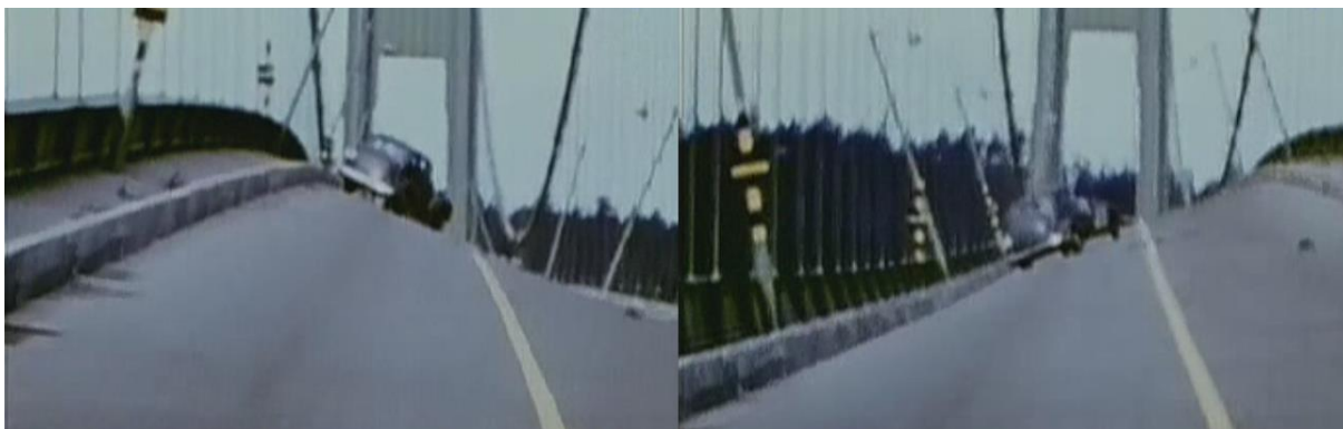
Obr. 7.12 Most Tacoma Narrows Bridge v krátkych okamihoch za sebou počas fúkania vetra a silného krútenia mosta
